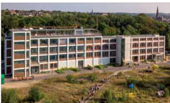
IBA Thüringen, Eiermannbau Apolda, Quelle: Webseite IBA Thüringen
